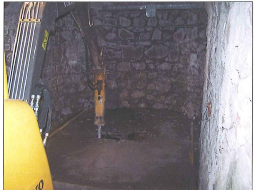
Puits MARIE – Démolition de la dalle de couverture
