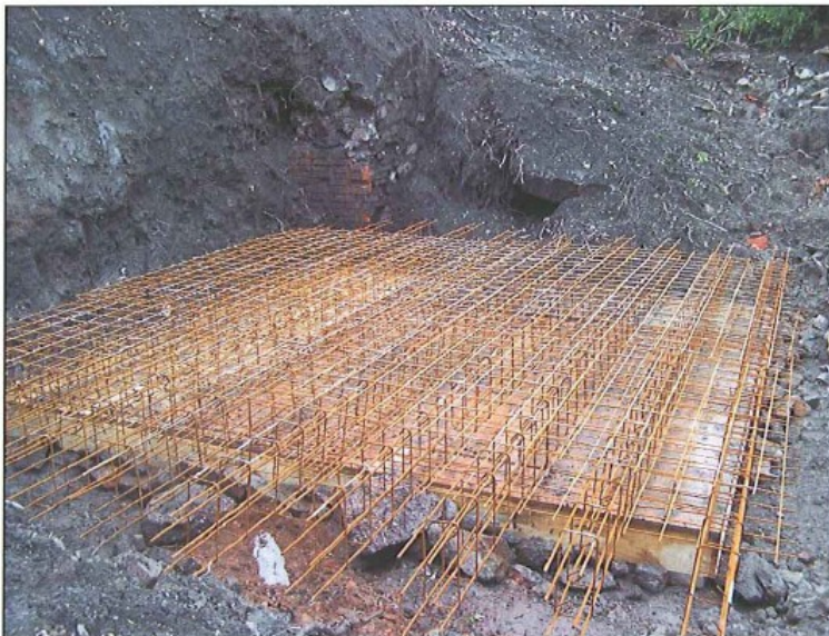
Puits STE FOY L'ARGENTIERE – Coffrage et ferrailage dalle
