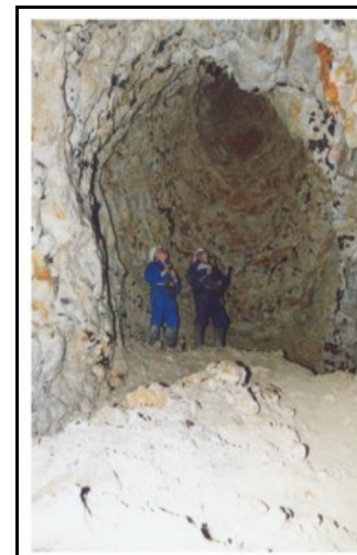
La cloche de fontis continue à se développer vers la surface, provoquant l'effondrement superficiels. Le fontis prend la forme d'entonnoir stable. Suite à l'altération des terrains des terrains de surface, une forme d'entonnoir stable. Le cône d'éboulis a rempli la cavité souterraine.
