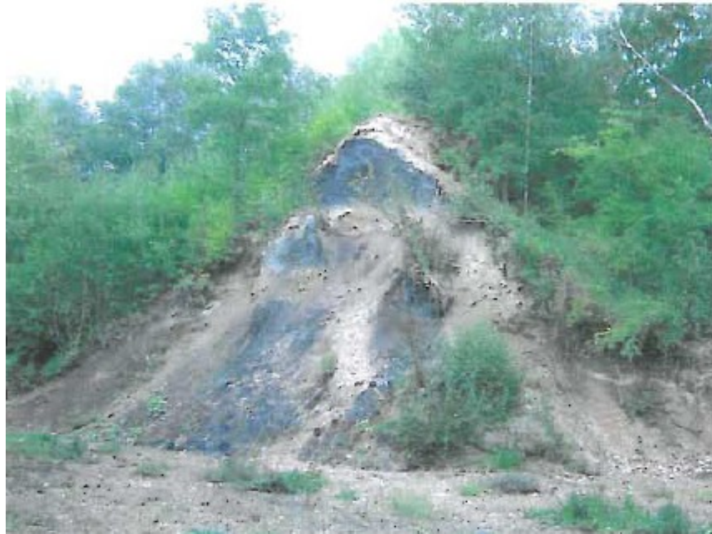
Emprunt sur le flanc du terril de Largentière
