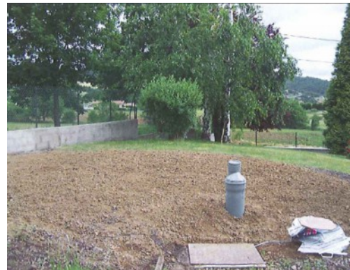
Puits Fenoyl après travaux
