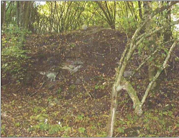
Puits STE FOY L'ARGENTIERE – Avant travaux – Tumulus surmontant le pu
