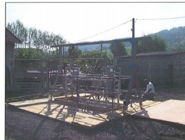
Puits NEUF – Platalage de tête, barrières, portique et nacelle
