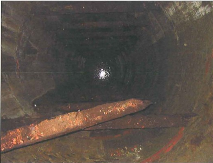
Puits MARIE – Avant travaux – Intérieur puits, moises
