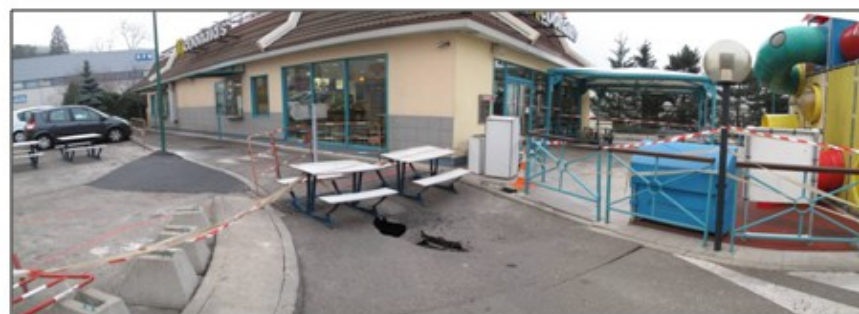
Mars 2009 : reprise d'effondrement du Mac Donald
