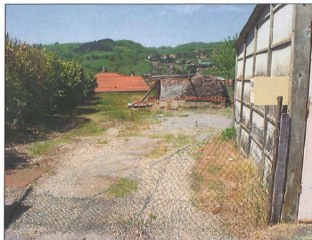
Puits NEUF – Avant travaux – Tête du puits
